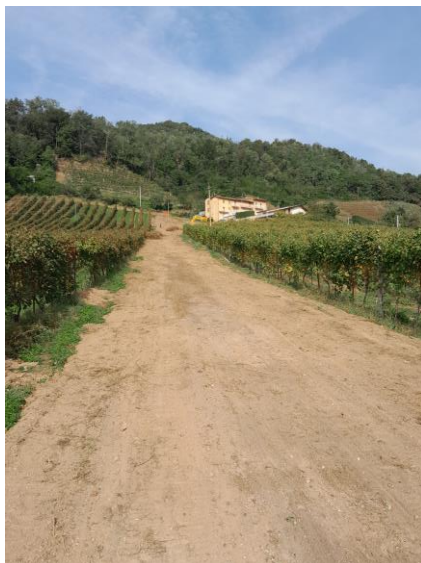
Formazione della pista di accesso al cantiere
