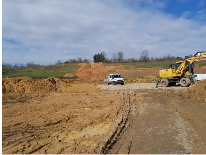
Lavori in corso nel Parco dei Colli
