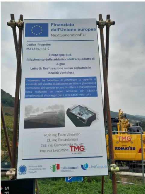
Cartello informativo intervento cofinanziato dal PNRR
