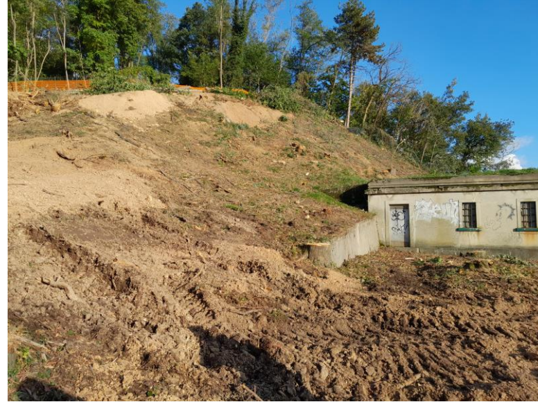
L'area del nuovo serbatoio pulita e la vecchia camera della Ventolosa da demolire
