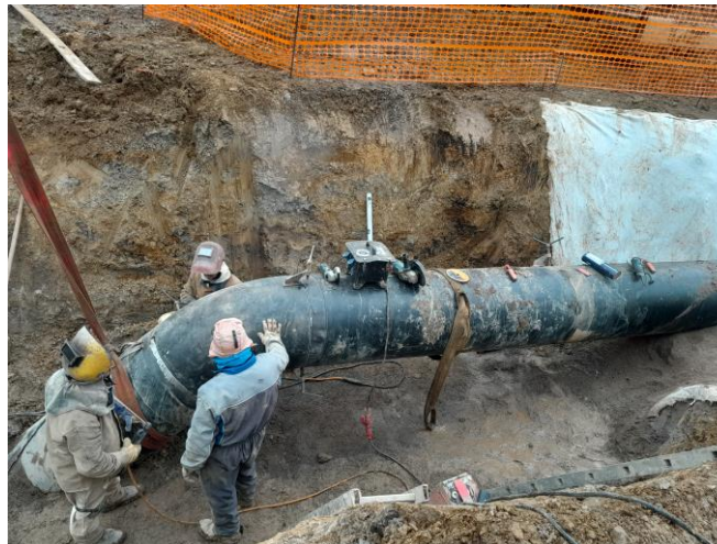
Lavori di saldatura e posa pezzi speciali
