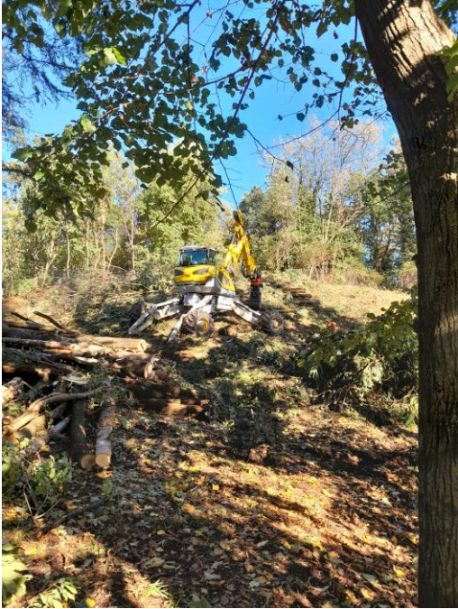
Pulizia dell'area destinata al nuovo serbatoio
