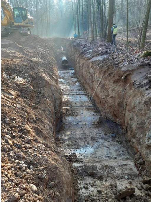
Posa tubazione sotto la pista ciclabile nel Parco dei Colli a Bergamo
