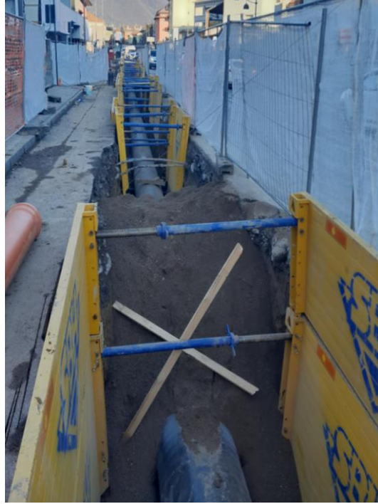
Teli antipolvere in centro abitato
