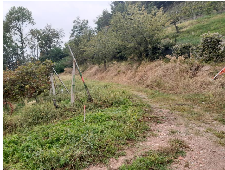
Viabilità di accesso prima dell'inizio dei lavori
