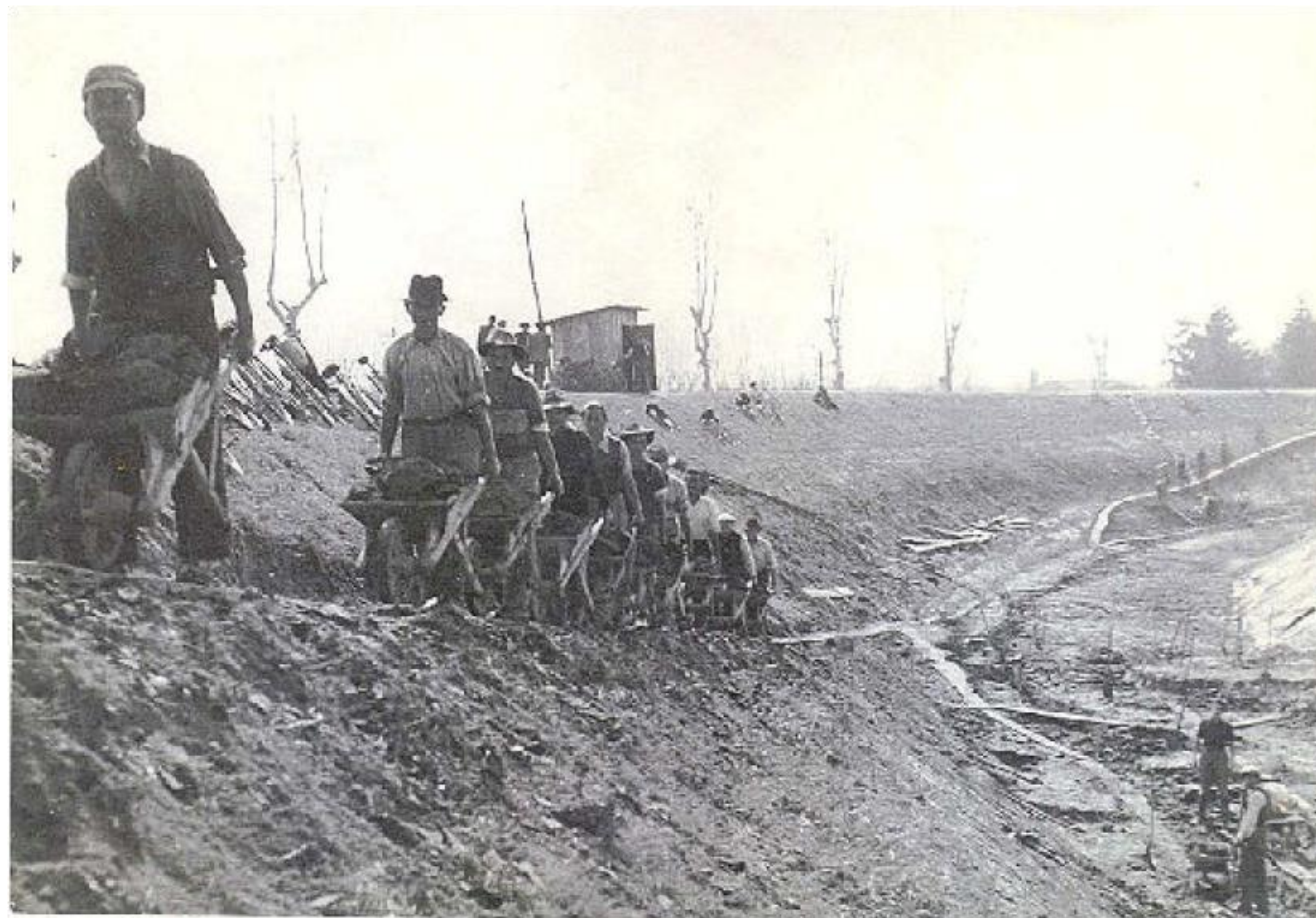
Cariolanti impegnati nella realizzazione del canale Bisatto (VI)
