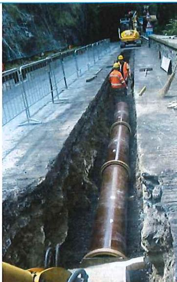
Fig. 8 – Particolare della posa tubazione.
