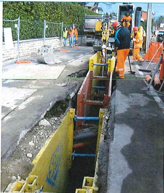
Fig. 10 – Blindoscavo lungo il tracciato di posa.
