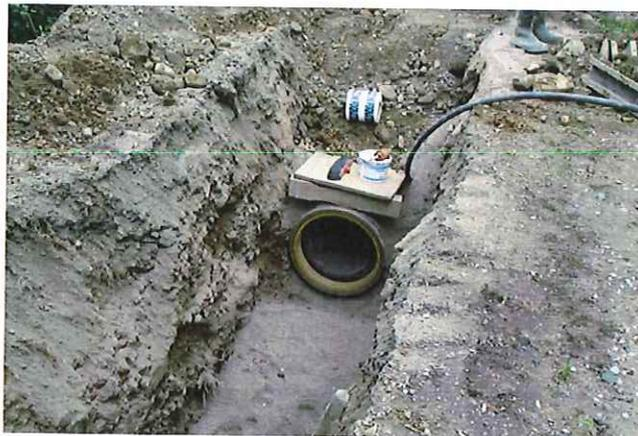
Fig. 11 – Particolare della posa del collettore.
