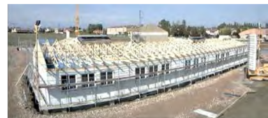
DOPO 15 GIORNI IL TETTO E' MONTATO
