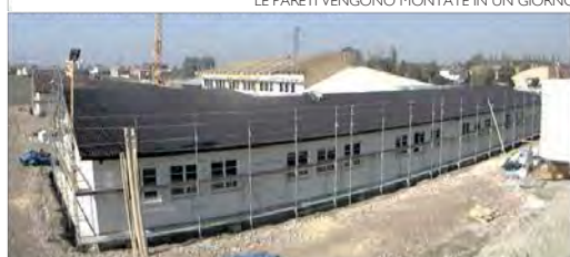
L'EDIFICIO VIENE COMPLETATO
